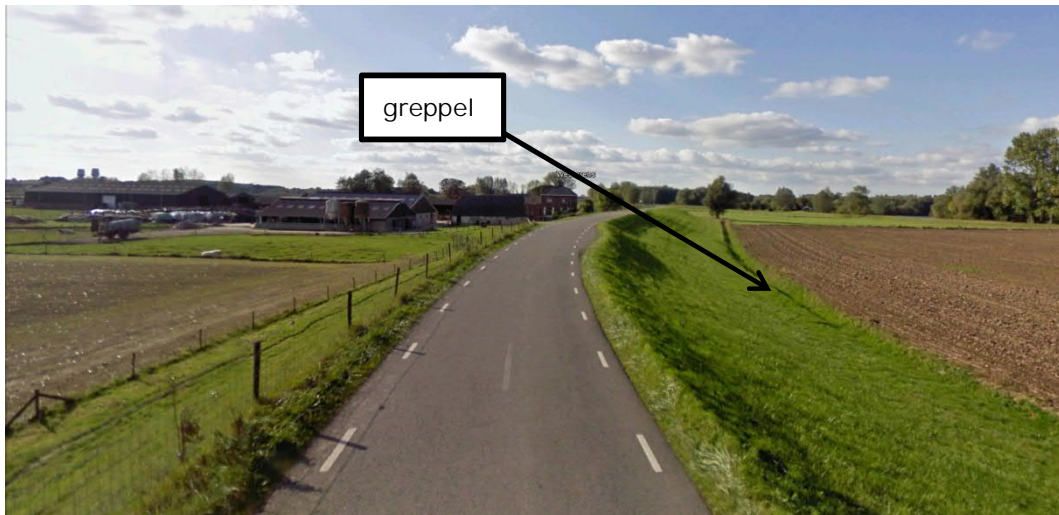
Figuur 8-3 Impressie van de betreffende dijk (Google Maps ©2015 Google) met voorland links dat zichtbaar hoger gelegen is dan het achterland. Er is behoudens ondiepe greppels geen sloot buitendijks
